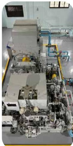
將飼水加熱設備熱源由中壓蒸汽改用鍋爐出口尾氣，減少中壓蒸汽使用量，提高發電效率，舊機組每度電需5,559Kcal，新機組每度電需5,477Kcal，每度電降低82Kcal。2023年節省天然氣**176,720**立方公尺。
